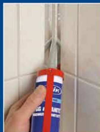
3. Påfør Fugemasse
